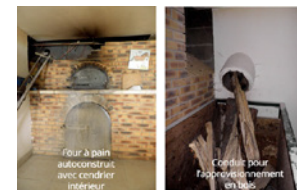
▲ Photos du four et du conduit d'approvisionnement.
