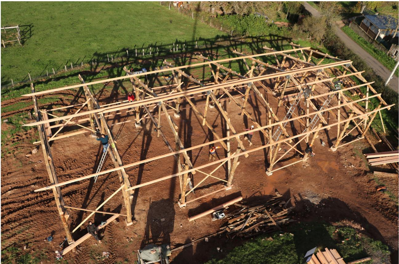
*Figure 19: Charpente montée vue aérienne*
