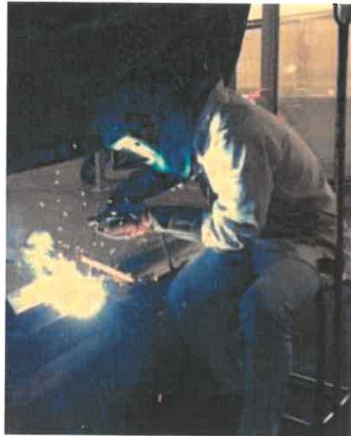
Soudage d'une cornière
