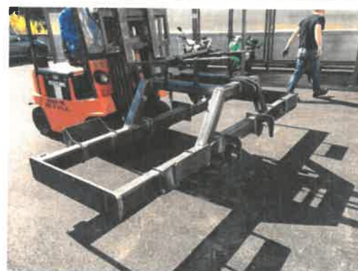
Mise en position du châssis pour le souder à plat
