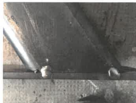
Pointage du 3 sur une tôle
